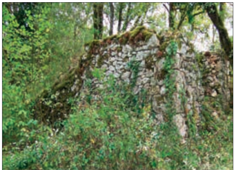
vue du four avec à gauche le plan incliné et à droite le "gueulard" effondré 6
