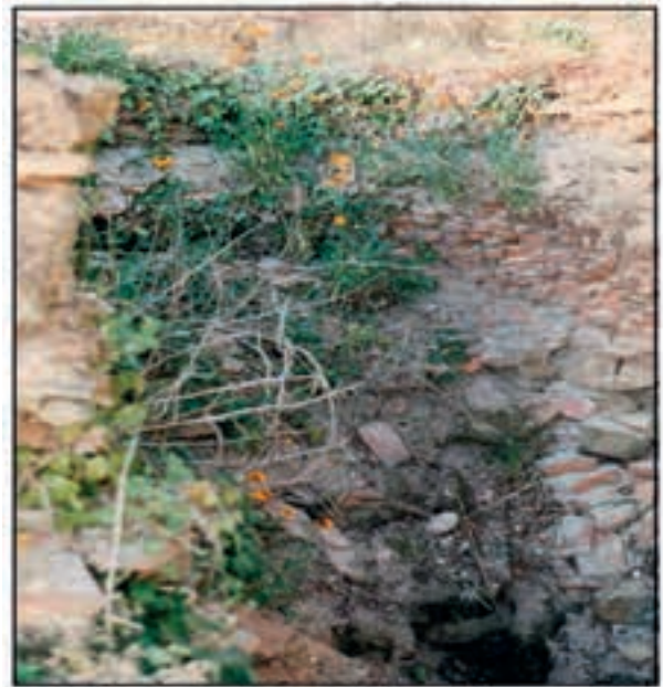
vestiges du four effondré 2
