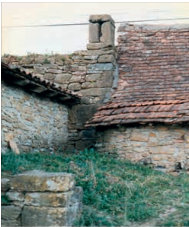
la cheminée du four 3
